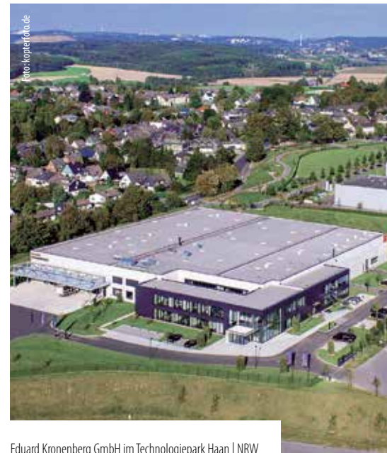
Eduard Kronenberg GmbH im Technologiepark Haan | NRW
